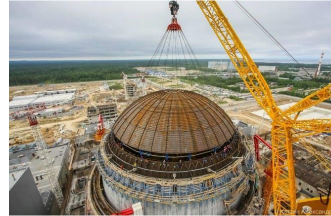
Fennovoiman referenssilaitoksen, Leningrad II 1. reaktorirakennuksen kupolia asennetaan.
